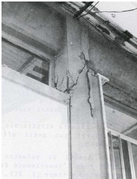
“Pilastro tozzo” (rottura fragile a taglio)
