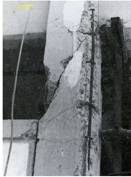
“Pilastro tozzo” (rottura fragile a taglio)
