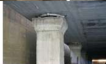
Immagine relative alle tubazioni dell'impianto idrico all'interfaccia, e di due colonne prima e dopo la realizzazione di un carter di protezione degli isolatori
