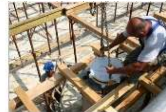
Predisposizione sul bagnolo dei fori per l'alloggiamento dei perni d'ancoraggio dell'isolatore, movimentazione
