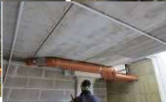
Immagine relative alle tubazioni dell'impianto idrico all'interfaccia, e di due colonne prima e dopo la realizzazione di un carter di protezione degli isolatori
