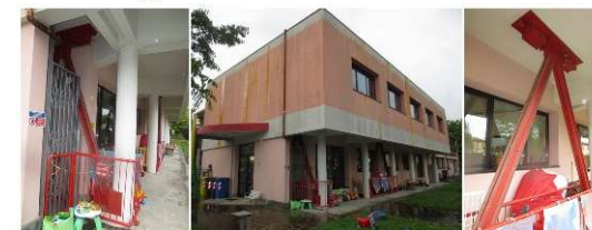
Presidi di sicurezza allestiti per la fruizione dell'edificio e per la salvaguardia dei dettagli strutturali
