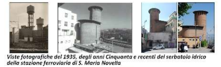
Viste fotografiche del 1935, degli anni Cinquanta e recenti del serbatoio idrico della stazione ferroviaria di S. Maria Novella
