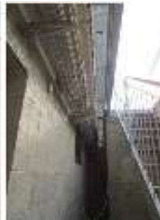
Predisposizione sul bagnolo dei fori per l'alloggiamento dei perni d'ancoraggio dell'isolatore, movimentazione
