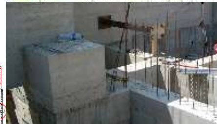
Vista di una delle dime d'acciaio posizionate come distanziatori sostitutivi dei dispositivi FV, prima del getto dell'impalcato mobile
