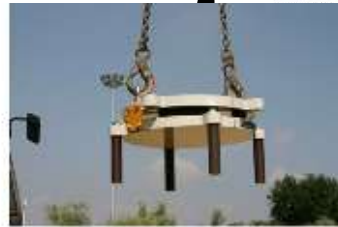
Predisposizione sul bagnolo dei fori per l'alloggiamento dei perni d'ancoraggio dell'isolatore, movimentazione
