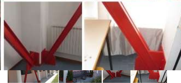
Dettagli esterni ed interni di realizzazione dei controventi
