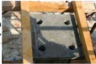
Predisposizione sul bagnolo dei fori per l'alloggiamento dei perni d'ancoraggio dell'isolatore, movimentazione
