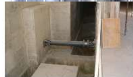
Vista di un dispositivo durante la fase di completamento della sovrastruttura
